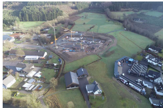
Nach Baubeginn, Dez. 2019.
