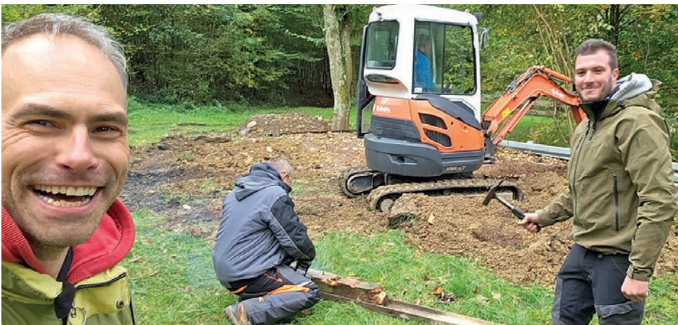
Bauarbeiten im Wieber
