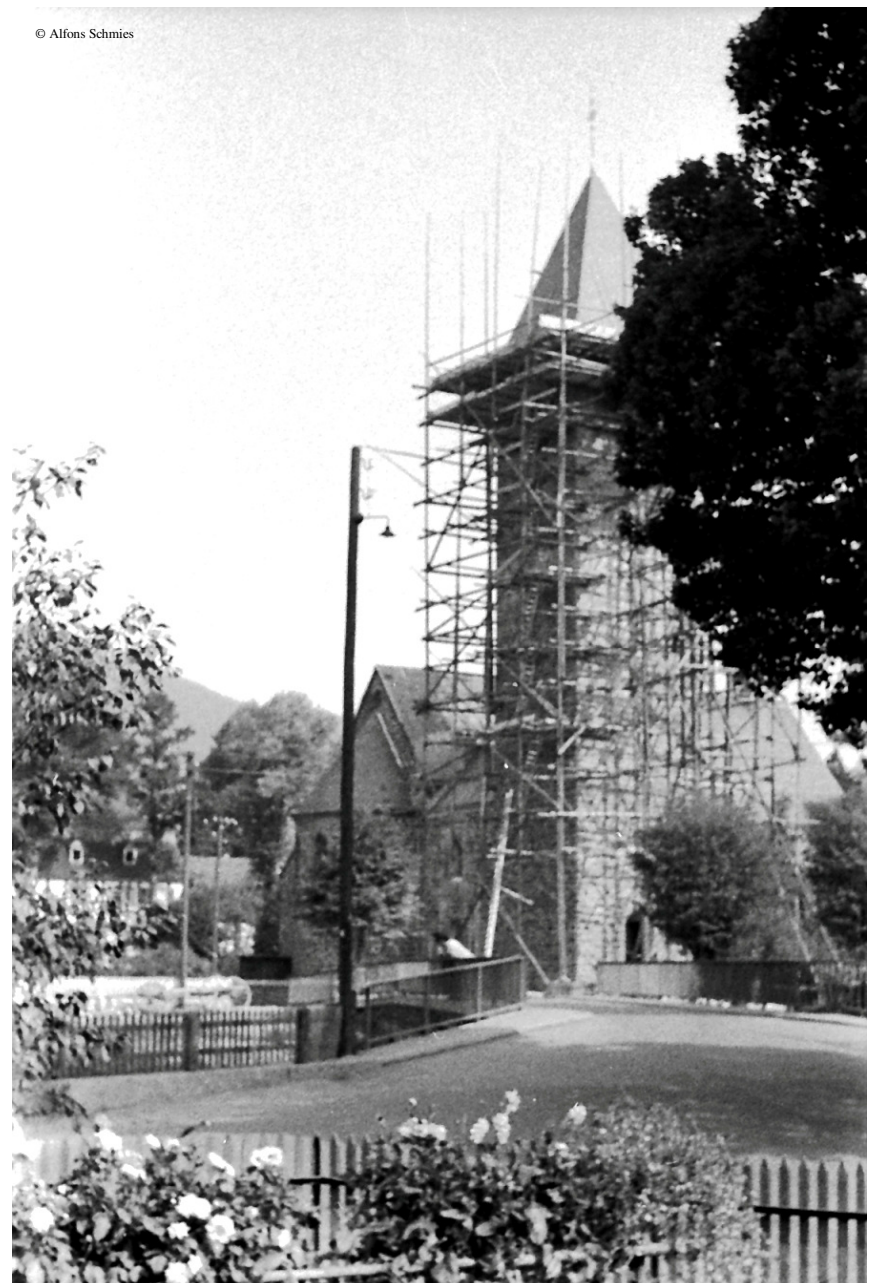
Der neue (aktuelle) Kirchturm
