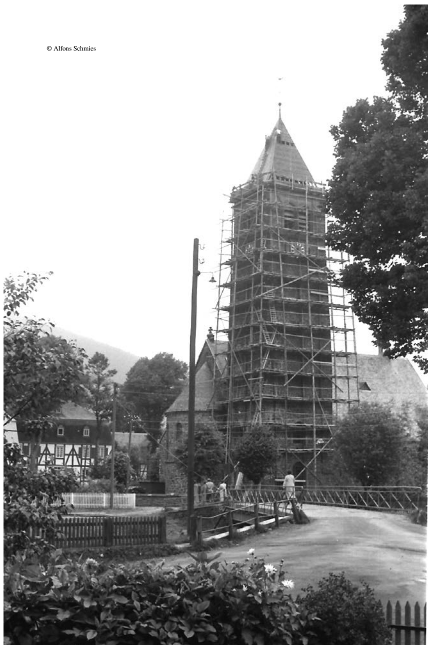
Der alte Kirchturm (1909-1958) ist zum Abbruch eingerüstet
