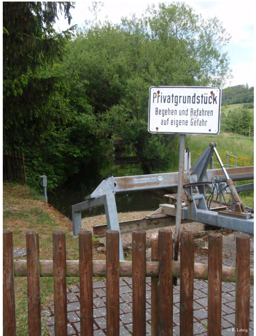
Der Einlauf zur Turbine
