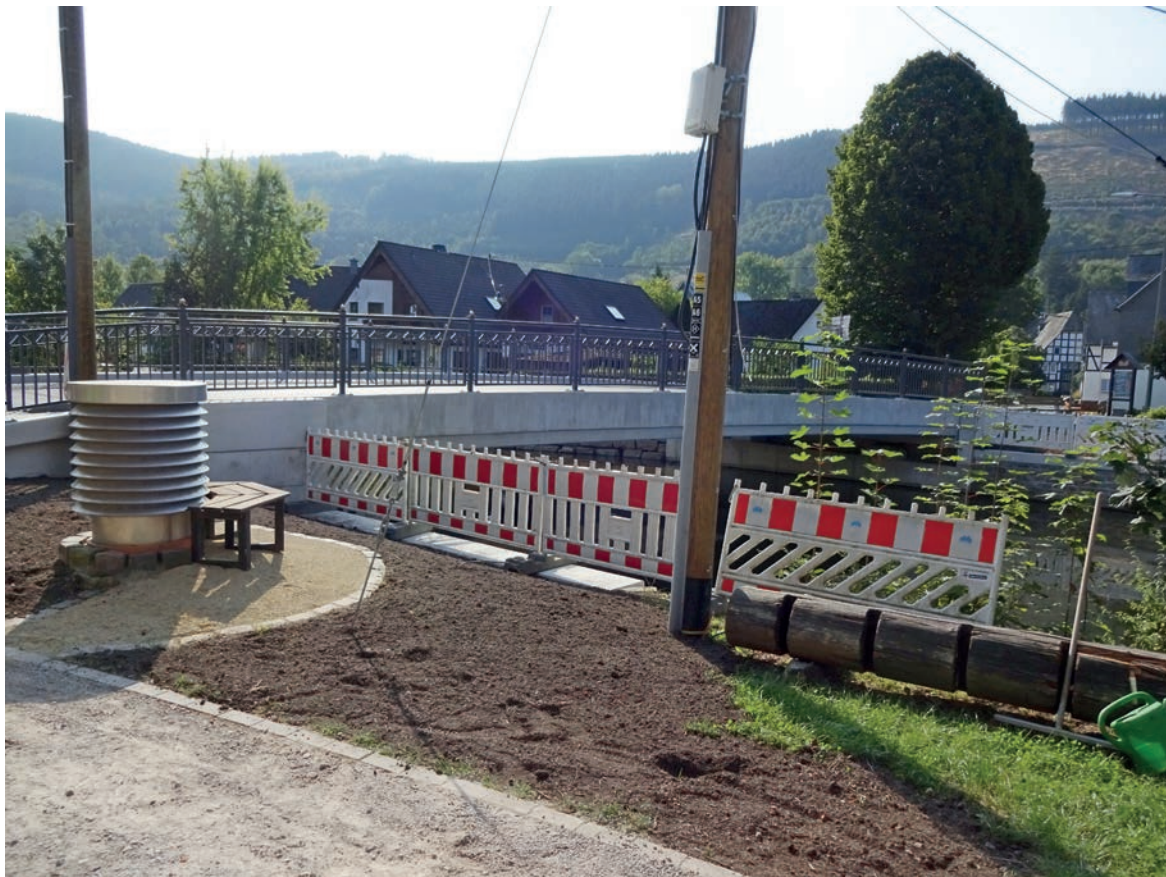
Neubau der Brücke Stand 02.09.2024 (Foto: H. Würde)
